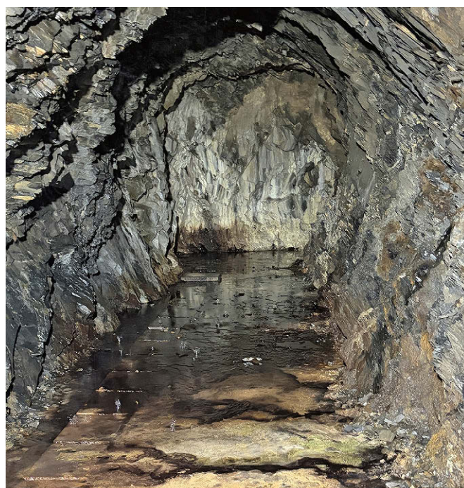
Der tote Gang am Ende der Staumauer der Talsperre Wendefurth:
