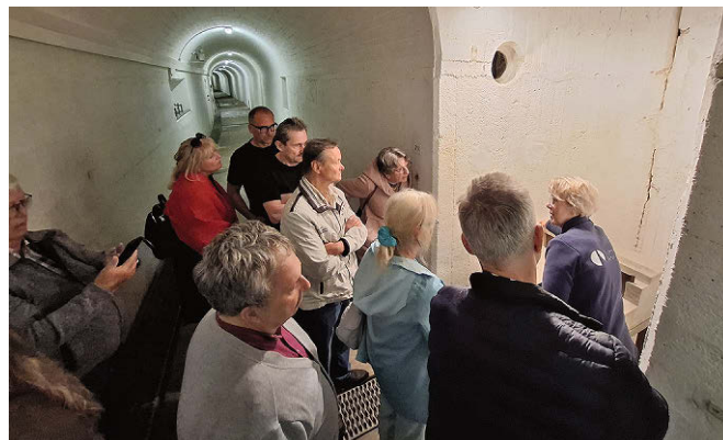
Ute Dorn vom Talsperrenbetrieb Sachsen-Anhalt erklärt die zahlreichen Meßgeräte im Inneren der Staumauer.
